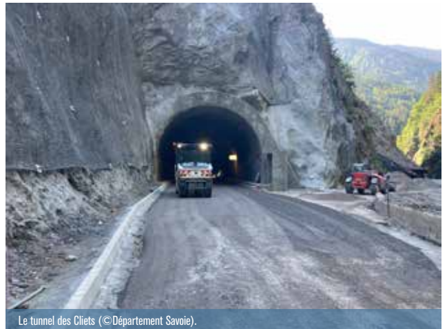
Le tunnel des Cliets (©Département Savoie).
