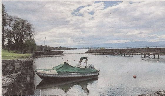
Le port de Chantrell aurait besoin d'une grosse rénovation...
