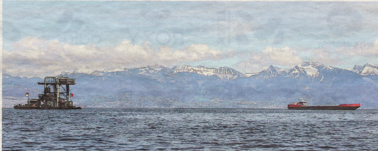
La barge de la Sagradranse qui drague le lac en face de l'embouchure de la Dranse.
